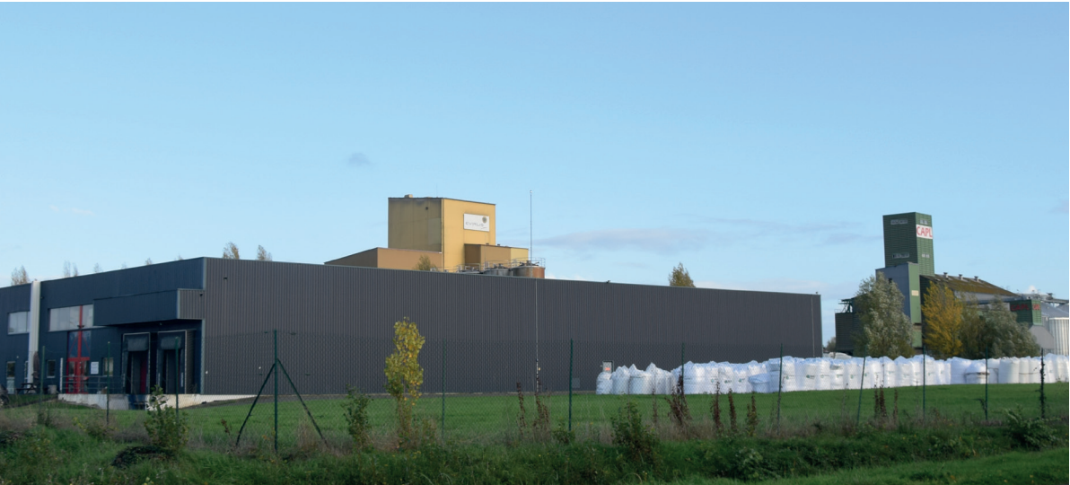
3-La zone d'activité Sud et ses silos, repères proéminents dans le paysage au Sud
