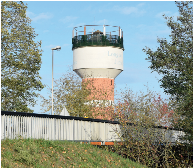
4-Le château d'eau au Nord du site en point haut
