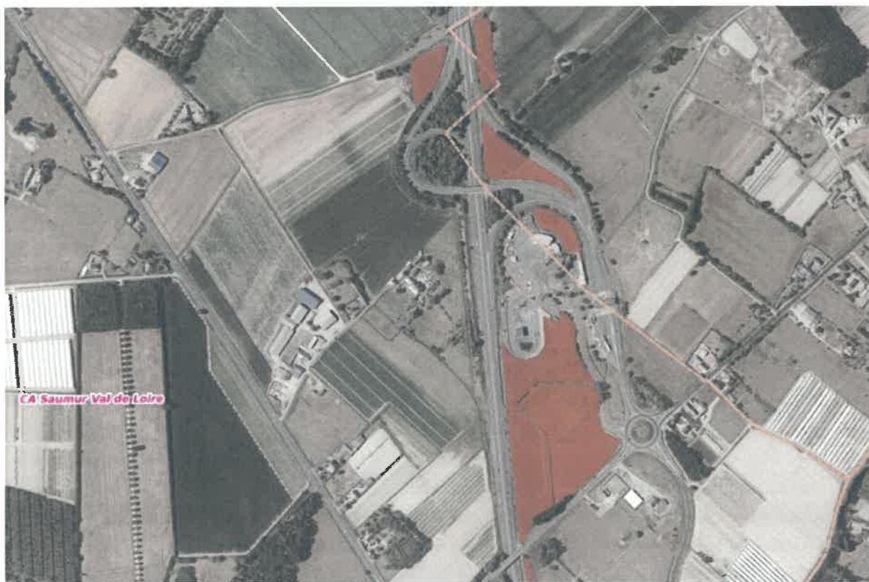
Délaissé autoroutier de Vivy – secteur péage de Vivy/Saumur sortie n°3
